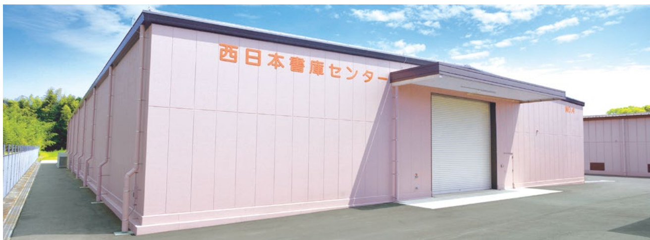
2017年9月竣工 第4号棟書庫
