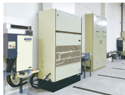
4号棟 定温・定湿管理システム
